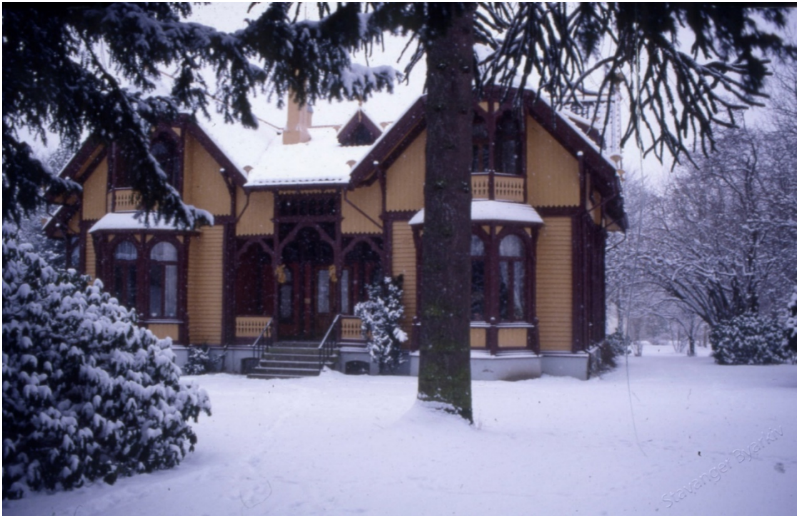
Fig. 6: Foto fra fasaden på nordsiden fotografert 1991 (Foto: Stavanger byarkiv).
