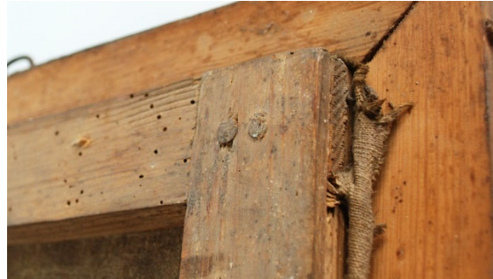
Figur 4) Nærøptak av øvre høyre hjørne av blindramme
