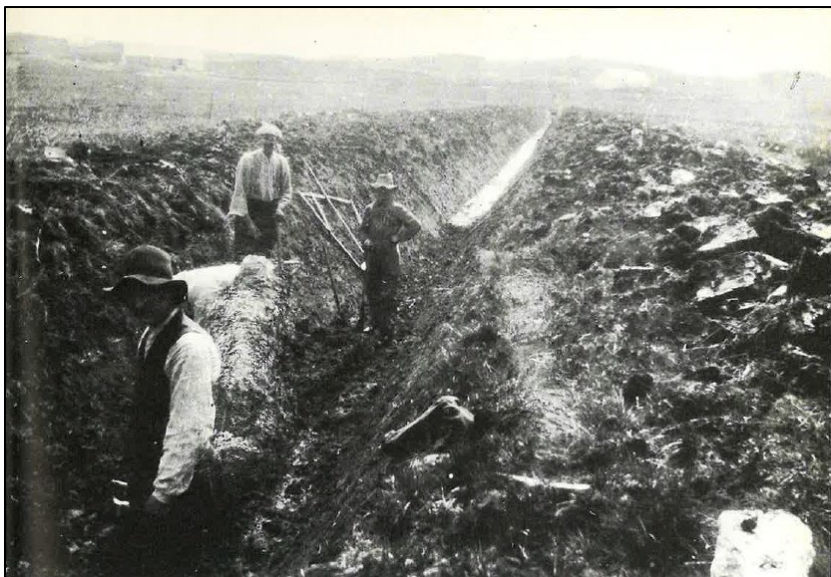
Figur 10 Dome på grøftegravning på Jæren, her frå Grude. Frå Lindanger 1987, s. 139.
