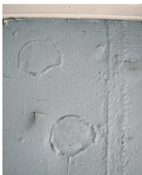
Fig. 74. Detalj av nordvegg med to innbøtte partier fra før seilet kom på veggen.
