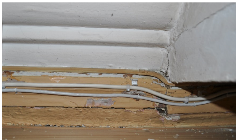
Fig. 18. Originalt plassert list i underkant av takbjelkene.
