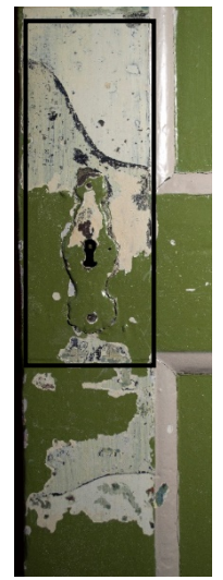
Fig. 85. Omriss av 2 beslag-imitasjoner rundt nøkkelskilt på vestre dørblad.
