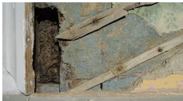
Fig. 25 B. Detalj av malt lerret under listene for pussbehandling.
