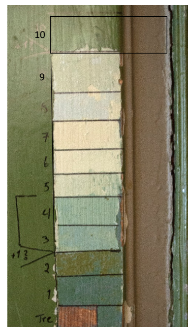
Fig. 43. Fargertrapp på dørblandet på nordvegg.
