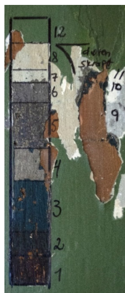
Fig. 45. Forsøk på fargertrapp på nordre dørblandet mot øst.
