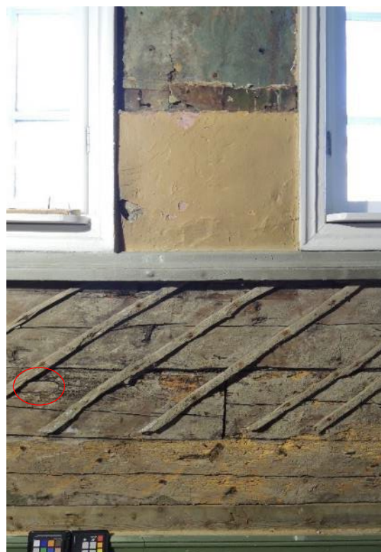
Fig. 29. Detalj av hele vegglivet på vestvegg. Original brystningshøyde sees mellom vinduene (list fjernet). Blågrønt lerret på øvre del av vegg.
