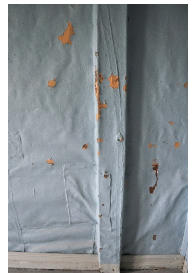
Fig. 75. Detalj av sørvegg med store pålappinger, bølget lerret og lerretstrukket loddrett bjelke.
