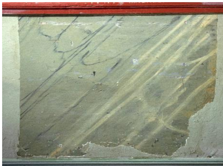
Fig. 28. Lag 6 på brystning. Avdekket felt av marmorimitasjonen.
