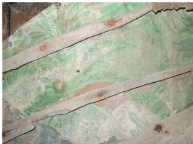
Fig. 25 A. Detalj av tapet under listene for pussbehandling.
