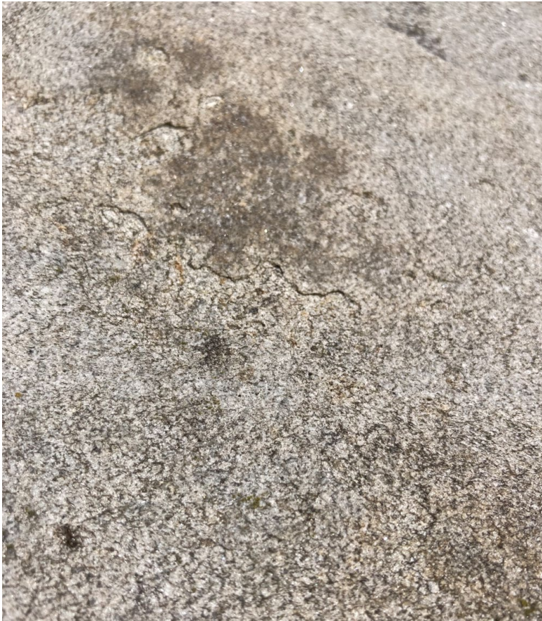
Figur 11. Detalj av sprekk/avskalling på bergflaten på Kråkhaug (Foto: Wenche Brun)
