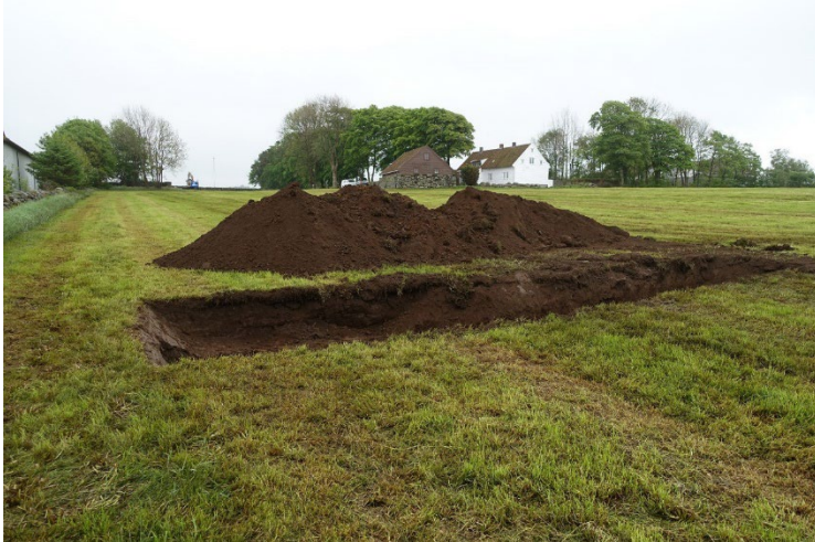
Figur 3: Profil 2 nærmast kamaren (id 250124) og Profil 1 i bakgrunnen ved gravemaskinen (id 250126). (Foto mot S)
