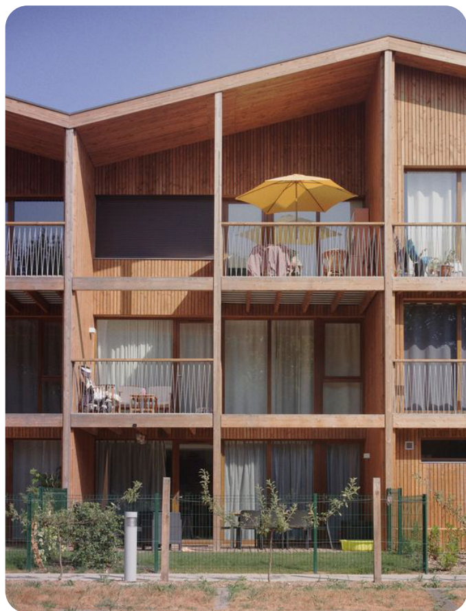
Figur 7.4: Utforming av fasade med en mer karakteristisk tilnærming (Foto: Tank).
